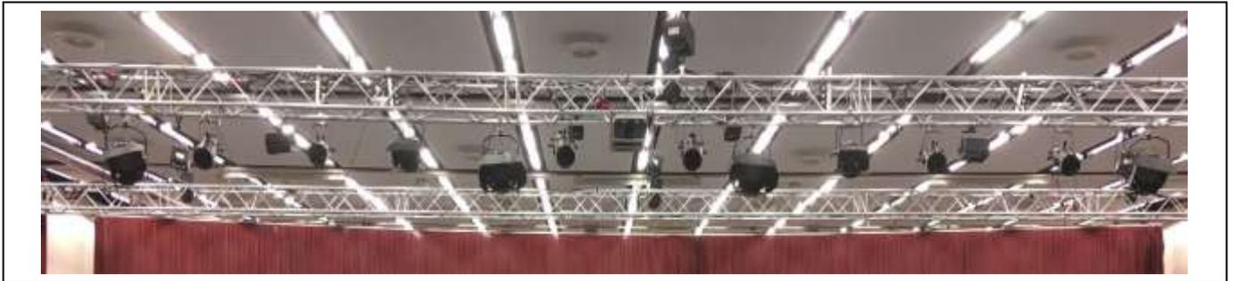
Die 1. Saal-Traverse ist fest verdrahtet. In diesem Zug befinden sich 2 x 6 Versätze á 2 kW, Direktstrom 2 x 16A CEE + 1 x 16A Schuko (Beamer), 1 x freie DMX Leitung über hauseigenen Splitter. Bestückt ist dieser Zug standardmäßig mit 6 x Arri 2 kW Stufenlinsen + 6 x ETC Source Four Profilern.
